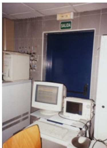
Figura 10. Salida de emergencia parcialmente bloqueada por una mesa de ordenador
