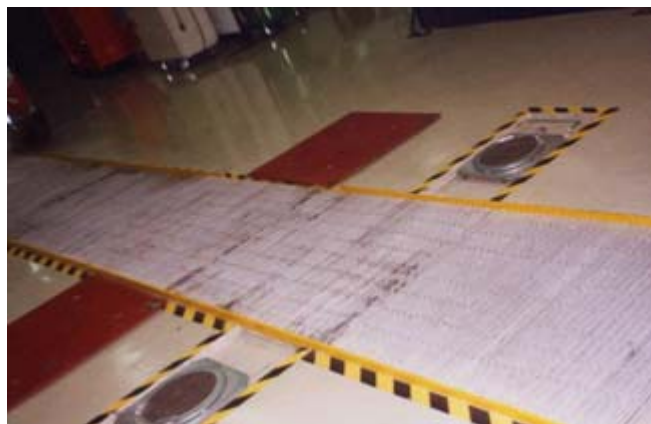
Figura 16. Ejemplo de foso protegido con cubierta y zócalo circundante
